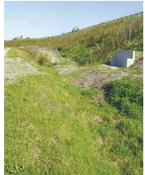
Sperrung des Abwassergrabens durch Kies und Bewuchs am Beginn der Neubaustrecke
