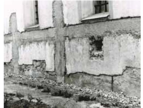
Die Mauern des Kirchenschiffs erhielten ein "Betonkorsett", die Fundamente wurden mit Beton ausgegossen.
