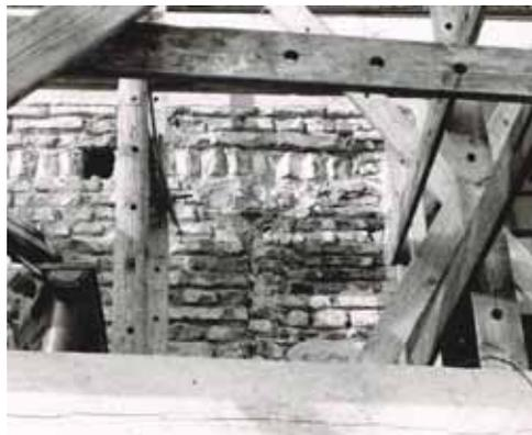
Unter dem Dachsim an der Südseite verlief ein romanischer Fries, ein "deutsches Band". Die Mauer aus Tuffsteinquadern war im Laufe der Jahrhunderte mit Ziegeln ausgebessert worden.
