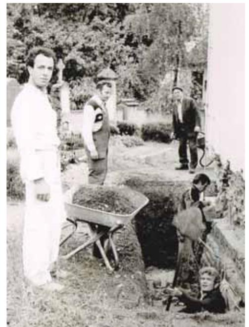
Die Ziegelfundamente des Turms wurden mit einem Lüftungssystem versehen.
