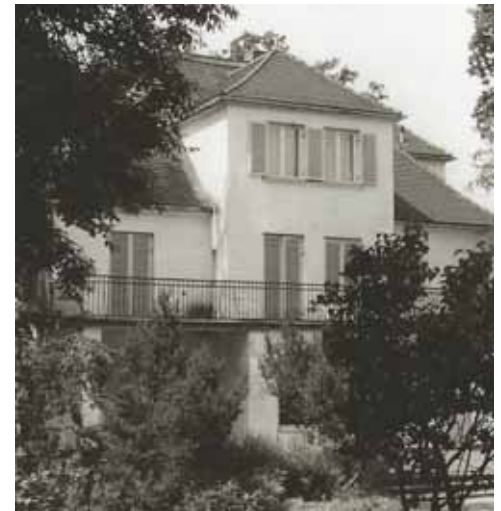
Die Villa des Ökonomierats Persch, Hausnummer Hollern 3, im Park gegenüber dem Lohhofer Bahnhof, wurde 2011 abgebrochen. (Bild: W. Buchmeier, 1978)
