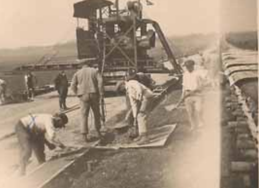
Hier wird die Brücke über die Bahnlinie gebaut. Der Echinger Landwirt Josef Seemüller sen. (links im Bild angekreuzt) gehörte einem Arbeitstrupp an.
