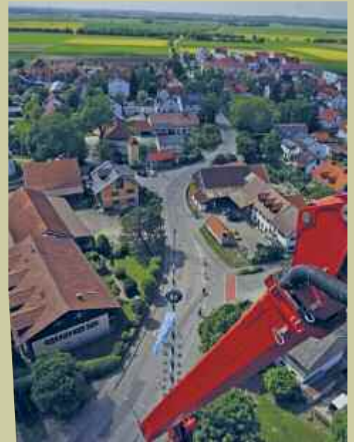
Der Blick von der Hebebühne 66 Meter nach unten auf die Echinger Straße.
