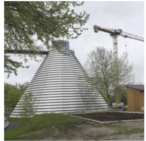
Der Faulturm im Klärwerk Marienhof. (Bild: G. Fiedler)
