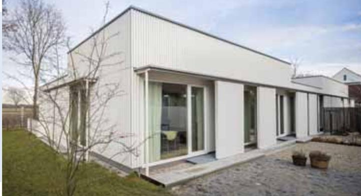
gefertigten Holzrahmenelementen und Decken aus Vollholzelementen auf. Die inneren Raumschalen sind weiß verkleidet, die Außenhaut aus gekanteten und zur Hinterlüftung gelochten Alu-Paneelen ist gestaltbestimmend und zudem unterhaltsfrei. Vor den besonnten Außenfassaden sorgen verschiebbare gelochte Schiebelemente im Doppelschienen-system für den sommerlichen Wärmeschutz, sind Vorhangersatz und lassen wechselnde Fassadenwirkungen zu.
