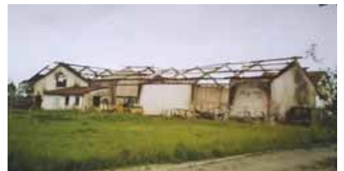
2005 brannte der Aussiedlerhof Riedmeier am Moosweg. (Bild: N. Widhopf)
